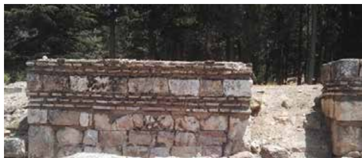
Mauerrest entlang des Cardo; in diesem Wechsel von Werkstein und Ziegel sind nahezu alle Bauten in Anjar ausgeführt.
