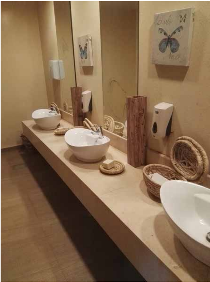
Moderne Sanitranlagen sind bereits fertig gestellt
